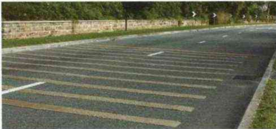
Pemasangan Rumble Area
