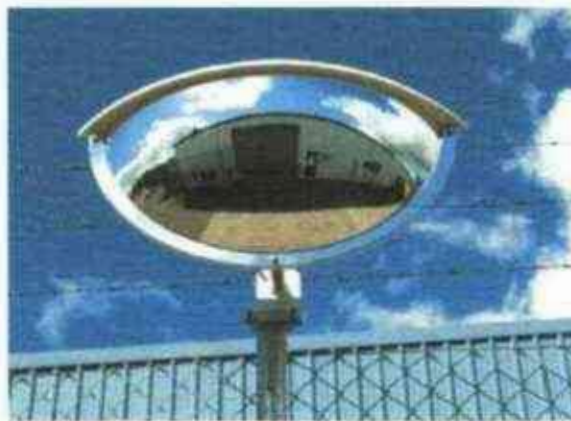
Gambar 43 Cermin Tikungan Setengah Lingkaran
