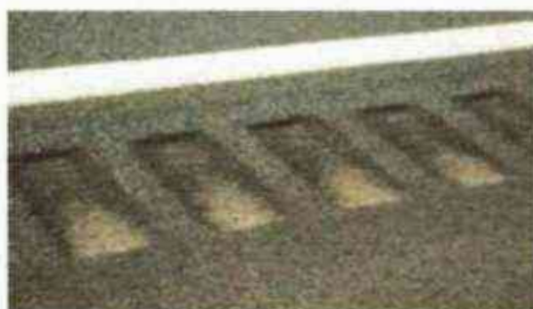
Gambar 61 Pemasangan Shoulder Rumble
