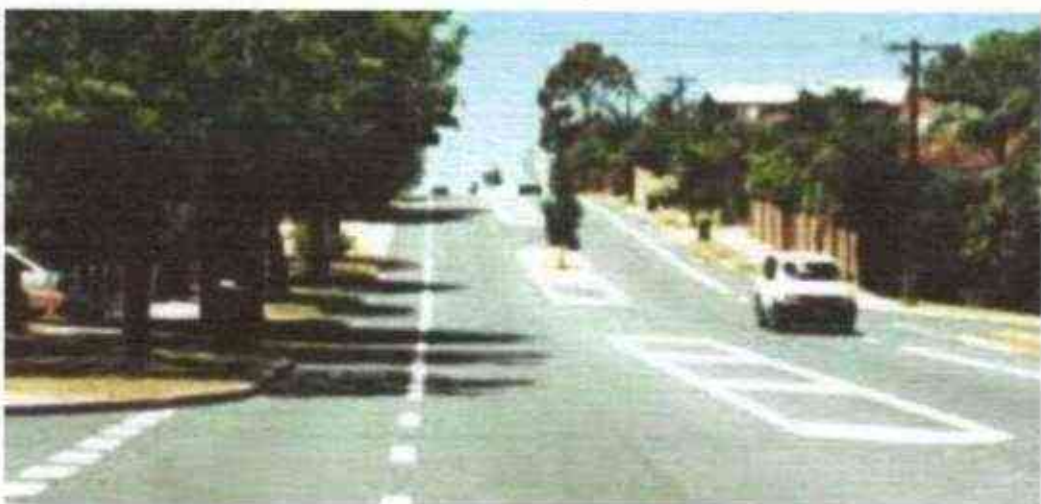
Gambar 58 Pulau Lalu Lintas berupa Marka Jalan
