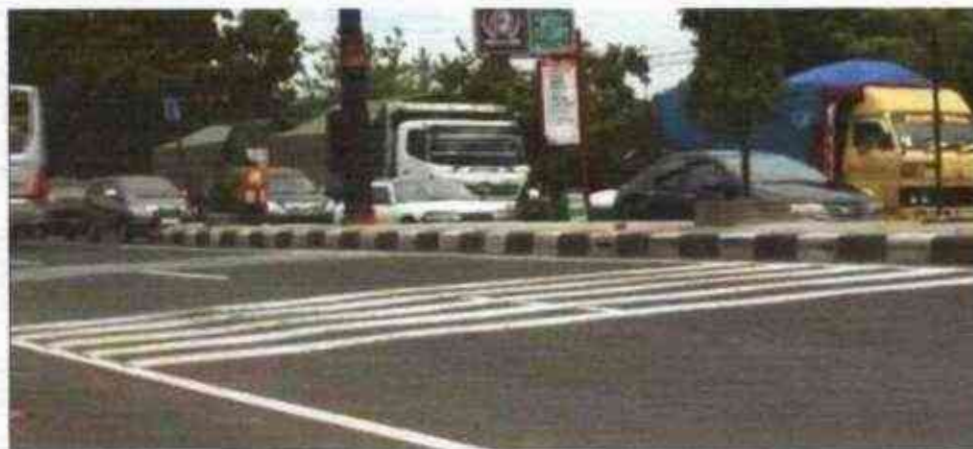
Gambar 60 Pemasangan Rumble Strip
