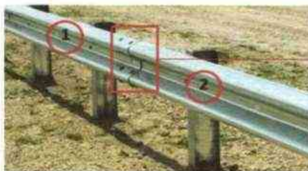
Gambar 13 Metode Penyambungan Beam Tampak Samping
